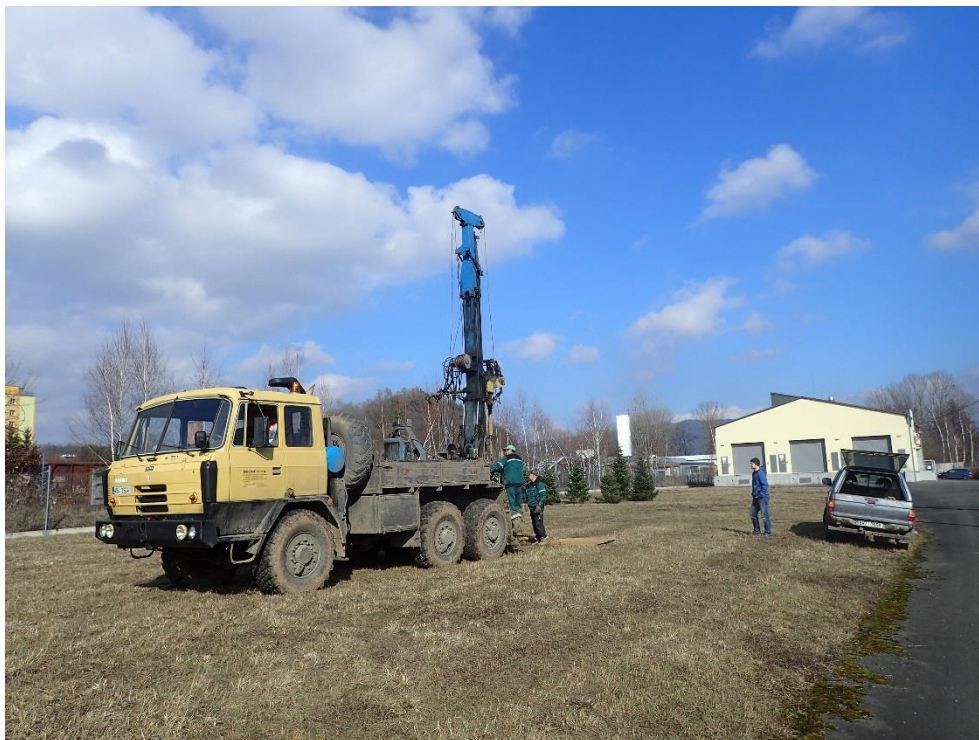
Foto 1: Realizace inženýrsko-geologického vrtu J20 na místě budoucí TMP Šumperk v km 43.050
